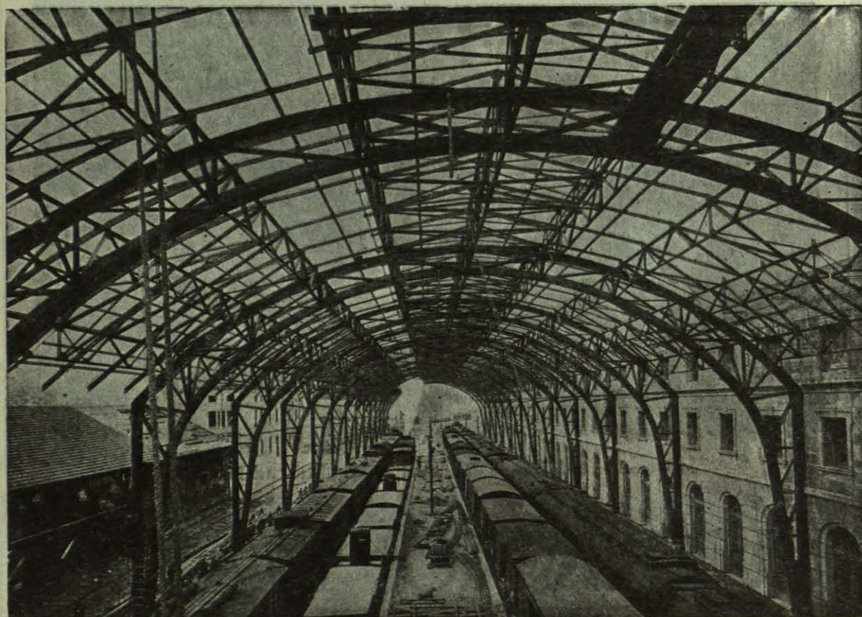
Estación internacional de Port-Bou.—Cubierta de andenes.—Agosto-Diciembre 1928.
