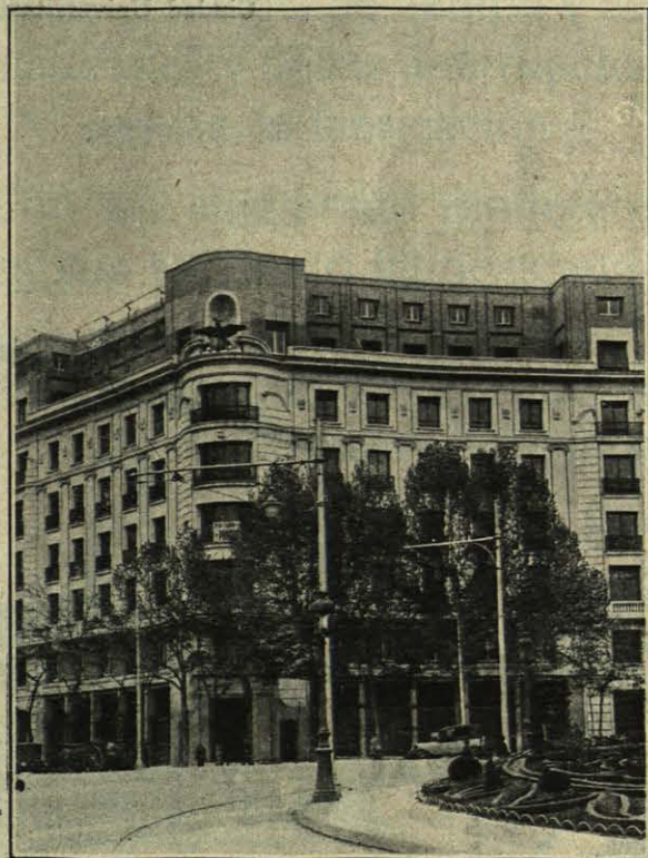
Casa propiedad de Le Phenix en la plaza de la Independencia, con veinte refrigeradores accionados por instalación central.
