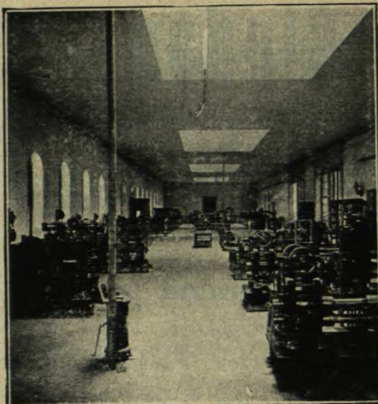
Fábrica de la Meneda y Timbre. Una de las naves pavimentadas con asfalto fundido.
